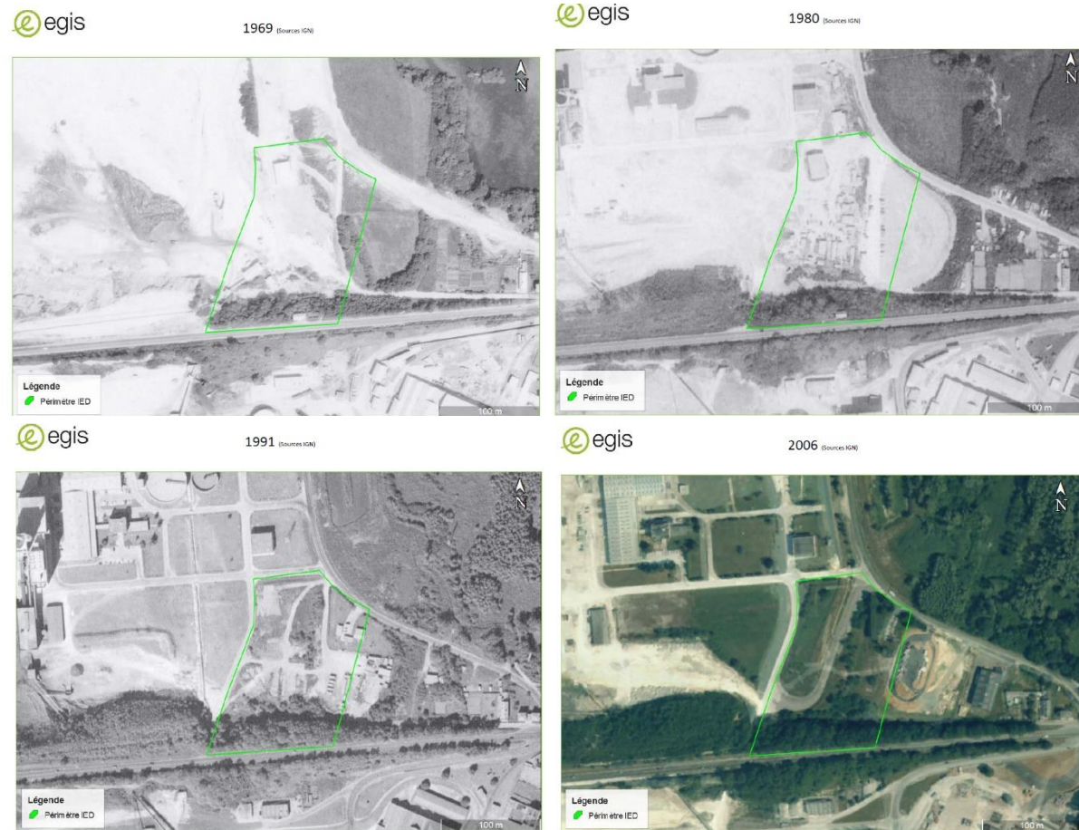
Figure 7 : évolution de l'occupation du sol sur le site d'Origny-Sainte-Benoite (Source : EGIS)
